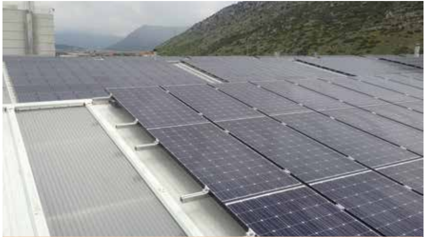
Burdur’da bir mermer fabrikanın çatısına kurulan 500 kWp’lik fotovoltaik sistem
