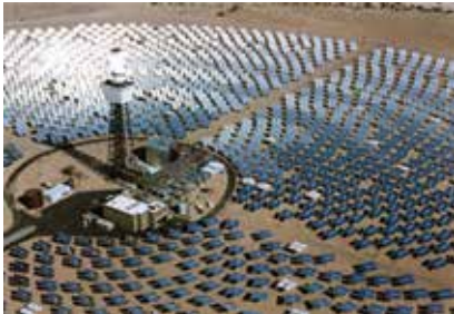
Şekil-6 Işınım yansıtımlı güneş enerjisinden elektrik üretim sistemi (California-ABD) [4]
