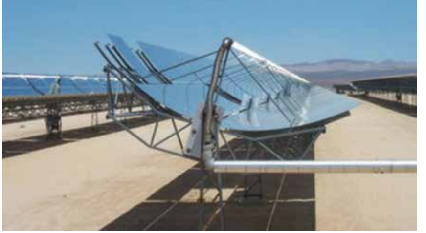
Şekil-5 Çizgisel (CSP) odaklı silindirik güneş elektrliği üretim sisteminin sistemin görünüşü[4].
